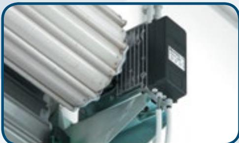
Motorizzazione laterale per serrande industriali di grosse dimensione con trasmissione diretta o rinviata a catena con paracadute di sicurezza incorporato.
